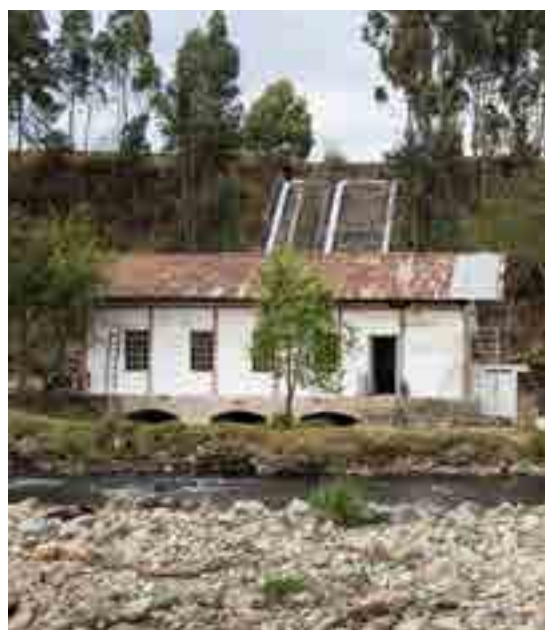
Antigua Planta Eléctrica
